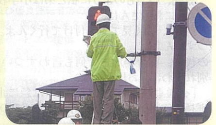
管内に設置された歩行者用信号機、カーブミラー等の点検・清掃を実施した。 (池田松川)
