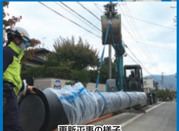
更新工事の様子
