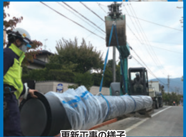
更新工事の様子
