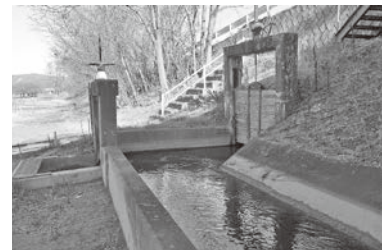
島立橋の架設にあわせて完成した導水路 (令和4年撮影)
