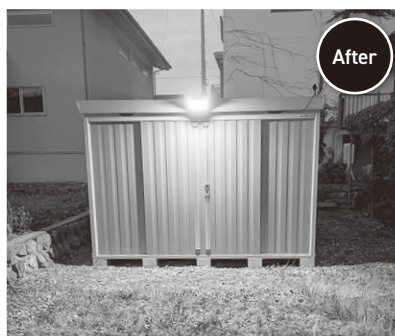
安全な場所に新しく設置されました
