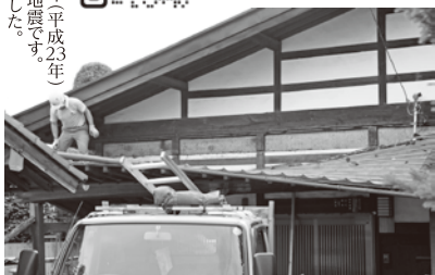
▲芳川地区でも多くの壁や塀、屋根瓦等に被害がでました
