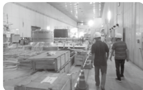
▲トンネルの先には発電所の巨大地下空間が広がっていました
