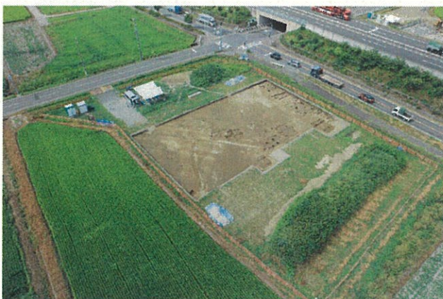
1区空撮状況（北東から）
