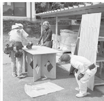
▲倉庫の補強材を作成中
