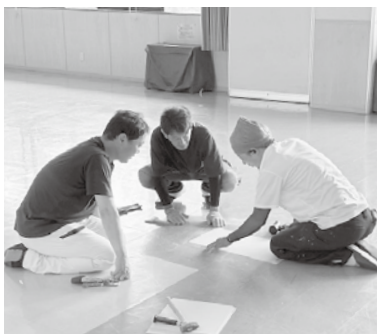
▲大会議室のタイルを補修
