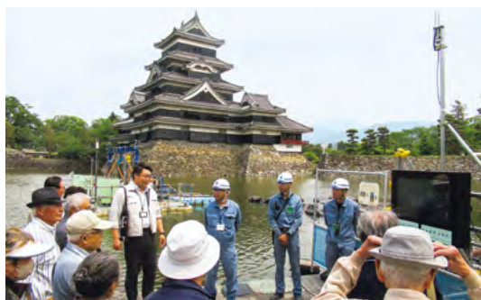
▲お堀に注目! 浚渫船が水面で作業中です
