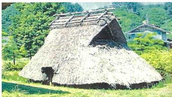
復元された竪穴建物跡 (立科町大庭遺跡)
