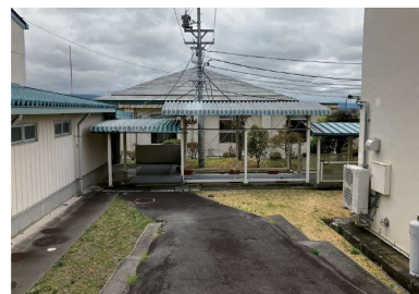
⑭ 北側道路と接続する舗装路
