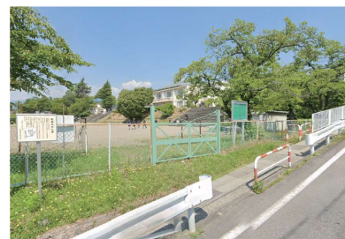
⑧ 敷地東側より運動場を望む
