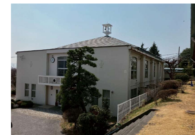
⑪ 屋内運動場より自治の鐘を望む
