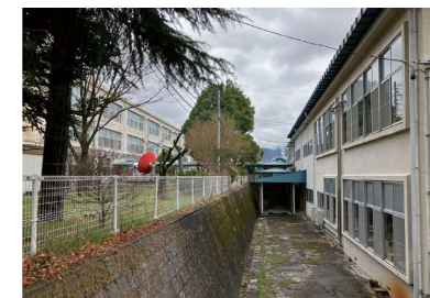
③ 特別教室棟北側の擁壁（高低差）
