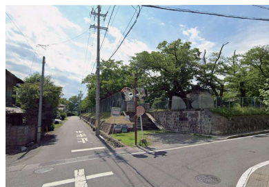
⑦ 敷地南側
