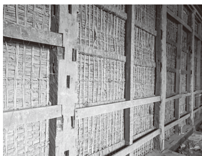
壁から現れた穴あきの転用柱 写真提供 旧開智学校
