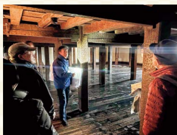
一般見学コースには無い天守3階(外からは見えない階)にて通し柱(3階～4階)の説明を受ける参加者
