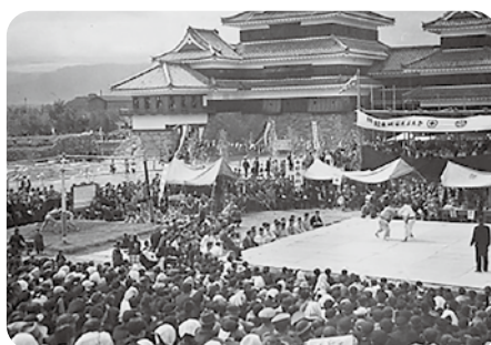
▲昭和30年10月1日 昭和の大修理落成祭(松本城アーカイブより)
