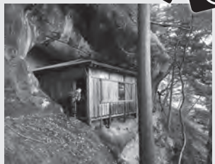
磐座に虚空蔵菩薩と神仏混淆の形態の社で懸造り、聖地の頭上に山城が築かれ、築城の標準が分かる。
