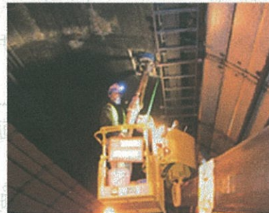
写真1 簡易ボーリング 実施状況
