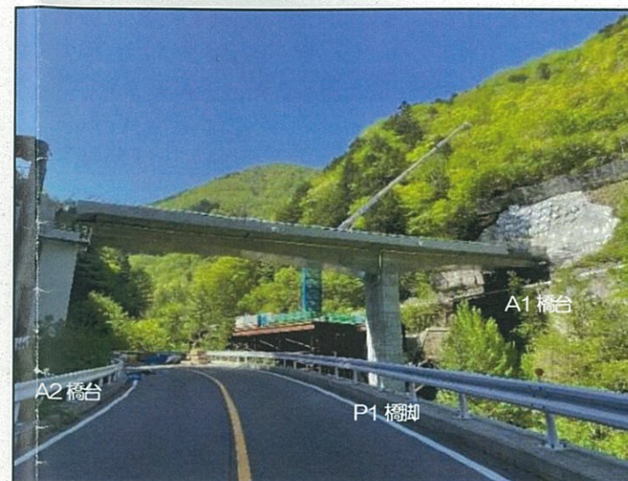
~大白川大橋全景~
