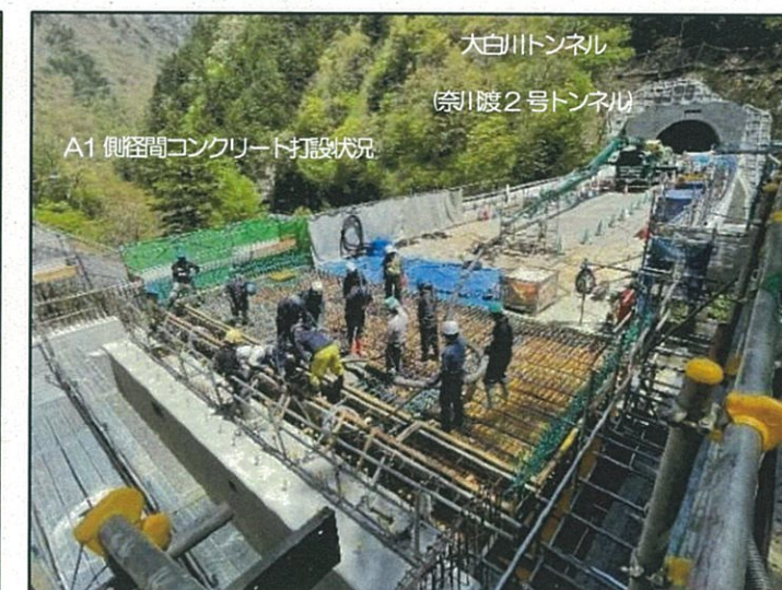
~A1 側径間施工状況~
