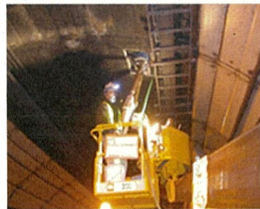
写真1 簡易ボーリング 実施状況
