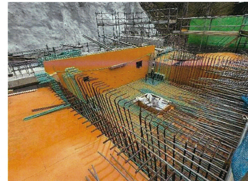
~A1側径間施工状況
