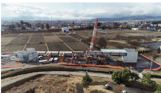
建設が進む中部縦貫自動車道
