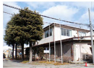
耐震補強工事が予定されている食肉衛生検査所
