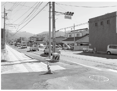
▲桜橋東交差点から見た和田線工事の様子
