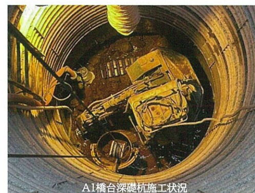
A1橋台深礎杭施工状況
