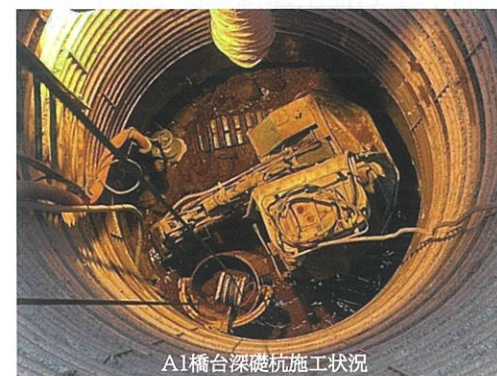
A1橋台深礎杭施工状況
