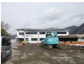
3月まだまだ工事中
