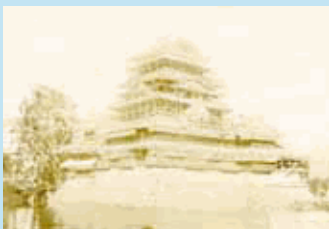
松本城の解体復元修理
