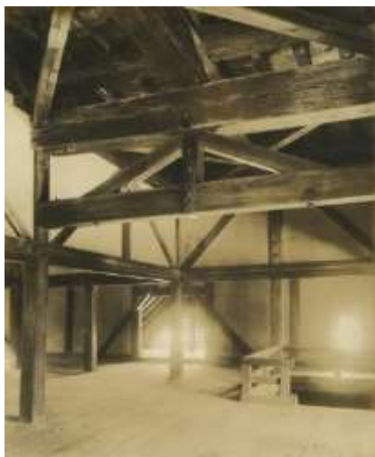
図版2 トラス構造を用いた天守4階の補強
