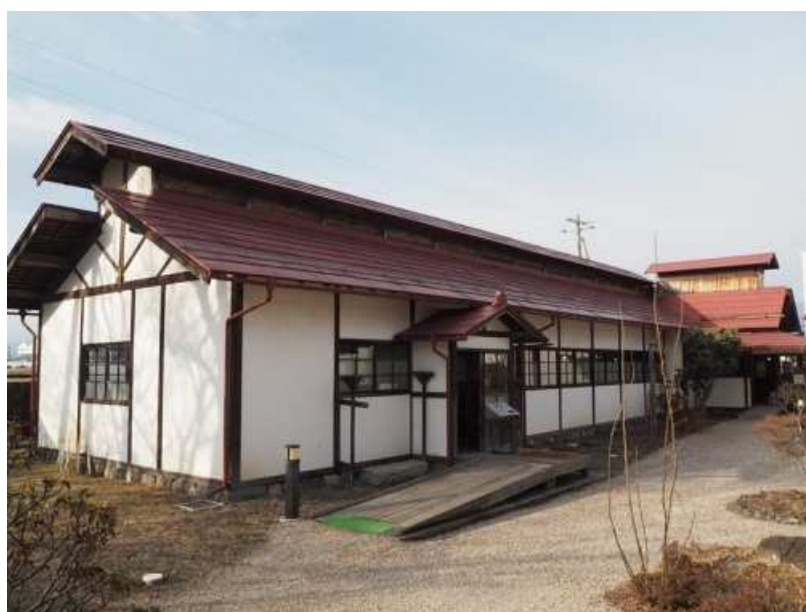
旧昭和興業製糸場 外観（北東より撮影）
