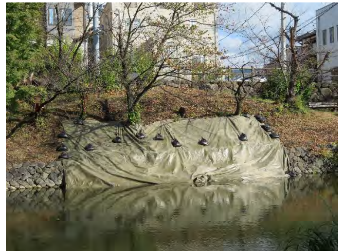
【シート設置後】
