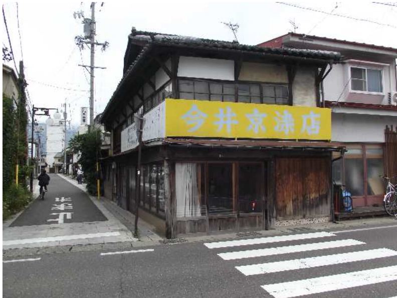
旧今井京染店店舗兼主屋 (北西から)
