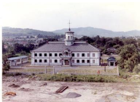
写真6 移築復原工事竣工時の校舎 （昭和39年頃）
