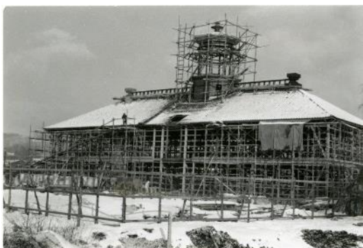
写真5 移築復原工事（昭和38～39年）
