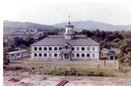
写真1 移築復原工事竣工時の校舎
