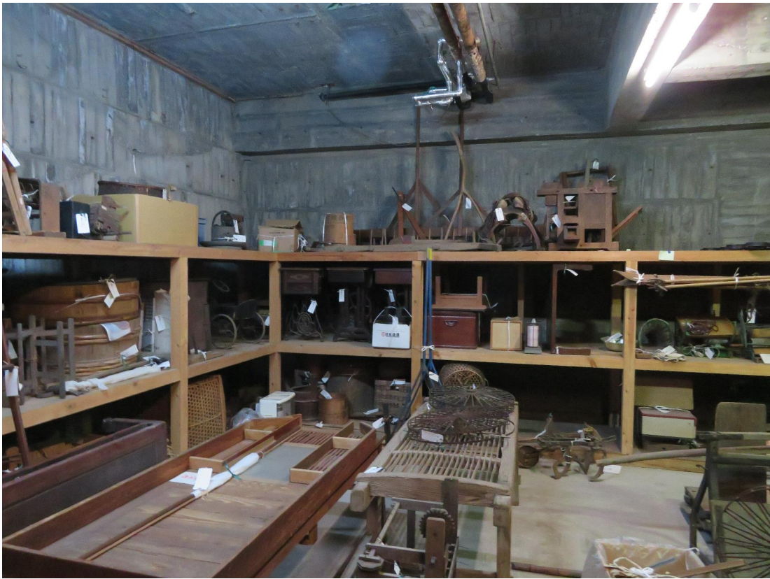
③：木製棚（H=1.77m）＋上部床組 ※収納物は別途 上部床組 柱：90×90、横架材90×150 ③-1：W2.95×H1.68×D0.3×2カ所、③-2：W3.34×H2.11×D0.3×1カ所、③-3：W2.65×H1.68×D0.3×1カ所
