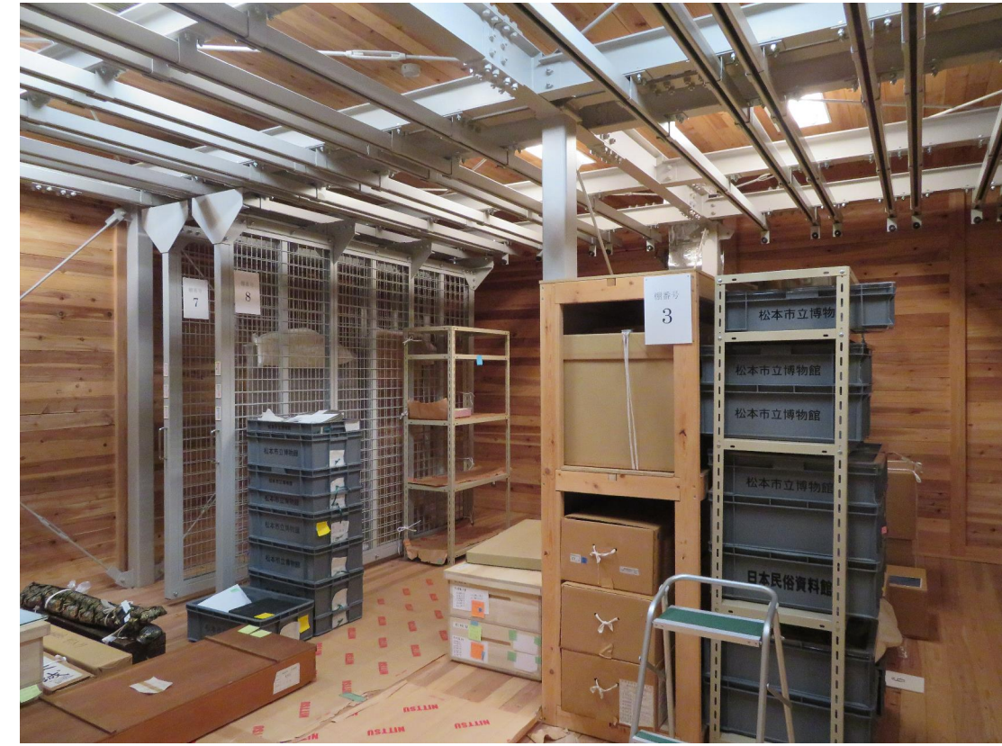
⑮ : 鋼製収納メッシュウォールパネル ※収納物は別途 柱: 120×120、横架材: 100×200 移動メッシュウォールパネル×2
