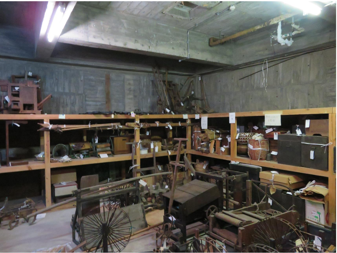
③：木製棚（H=1.77m）＋上部床組 ※収納物は別途 上部床組 柱：90×90、横架材90×150 ③-1：W2.95×H1.68×D0.3×2カ所、③-2：W3.34×H2.11×D0.3×1カ所、③-3：W2.65×H1.68×D0.3×1カ所
