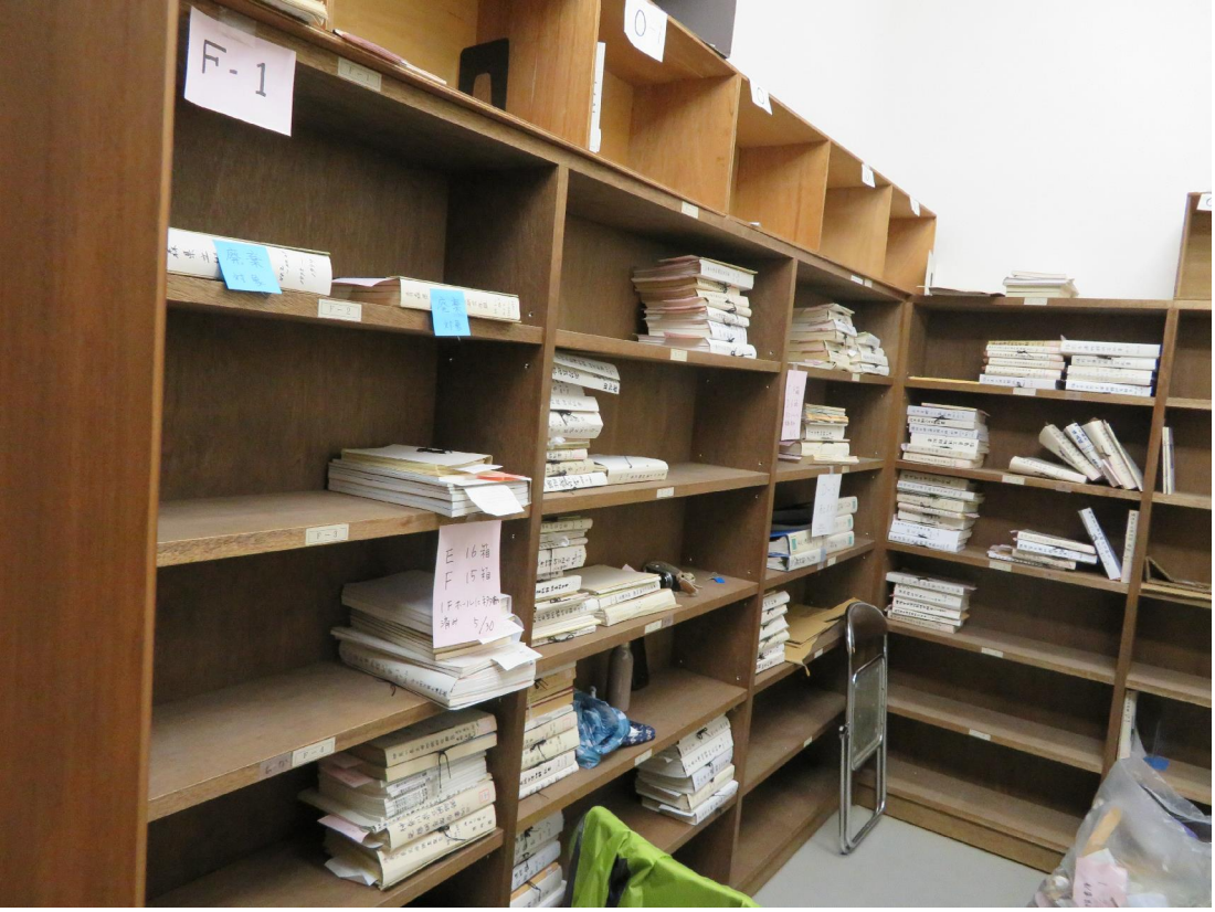
③：木製棚（H=1.77m）＋上部床組 ※収納物は別途 上部床組 柱：90×90、横架材90×150 ③-1：W2.95×H1.68×D0.3×2カ所、③-2：W3.34×H2.11×D0.3×1カ所、③-3：W2.65×H1.68×D0.3×1カ所
