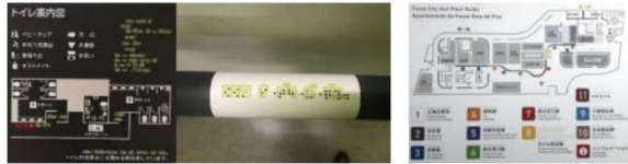
点字と一体となったサイン（左：トイレ案内、右：手すり） 視覚障がい者などにも配慮した色分け
