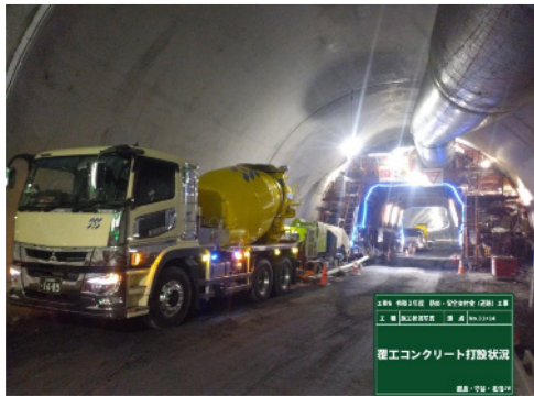
トンネル坑内
