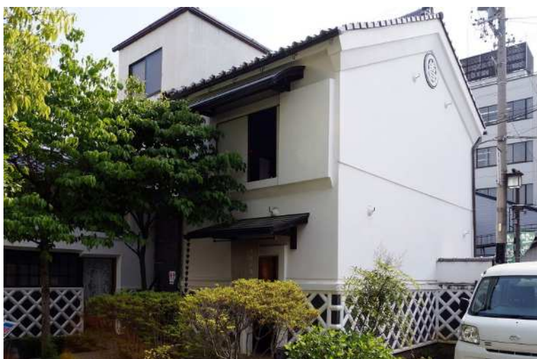
旧竹内度量衡店蔵座敷 (松本市はかり資料館 第二展示室) (北東から)
