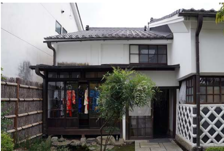
旧竹内度量衡店店舗兼主屋（松本市はかり資料館 第一展示室）東棟 （北から）
