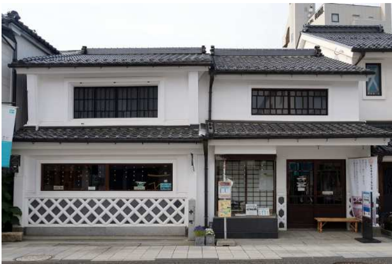
旧竹内度量衡店店舗兼主屋（松本市はかり資料館 第一展示室）東棟 （南から） 向かって右側が対象
