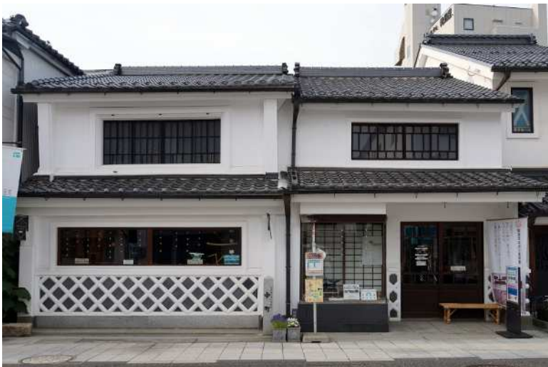
旧竹内度量衡店店舗兼主屋（松本市はかり資料館 第一展示室）西棟 （南から） 向かって左側が対象
