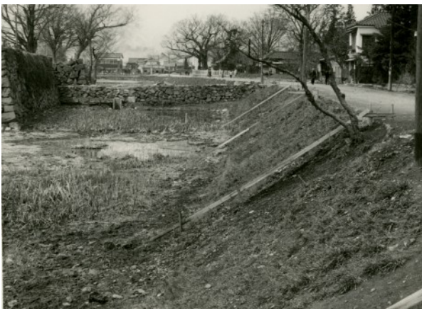
図版34 改修中の北外堀北面土坡（昭和31年）
