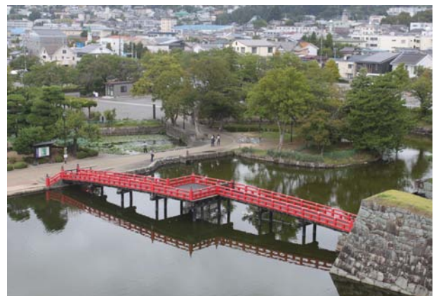
若宮八幡社跡・埋の橋
