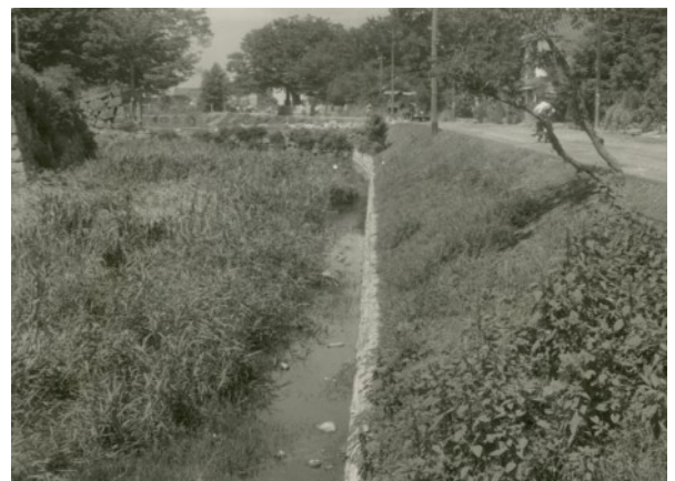
図版35 北外堀北面土坡の裾石垣（昭和31年）
