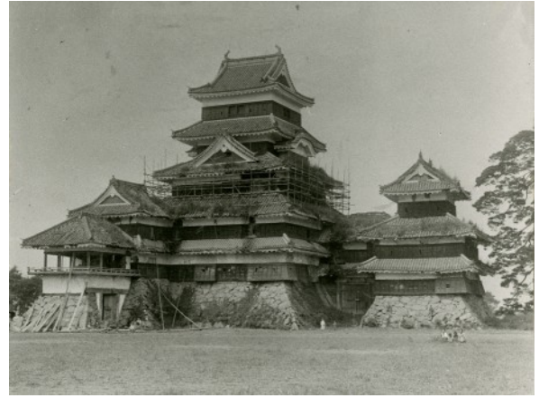
図版13 明治の大修理中の天守（明治36年～大正2年）
