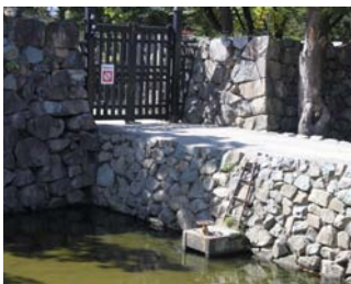
水門（北裏門土橋）
