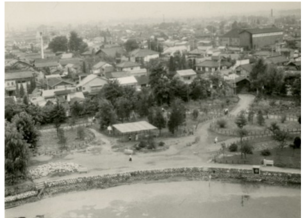
図版31 改修中の内堀南・西面石垣（昭和31年）
