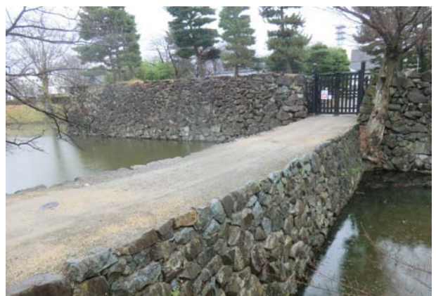
北裏門土橋、管理用門（北から）
