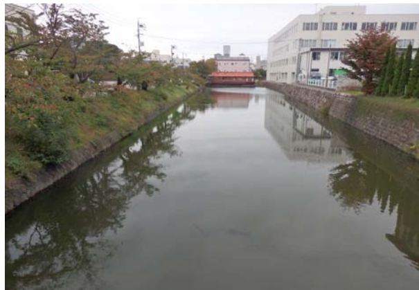
東総堀北半部南側（北から）
