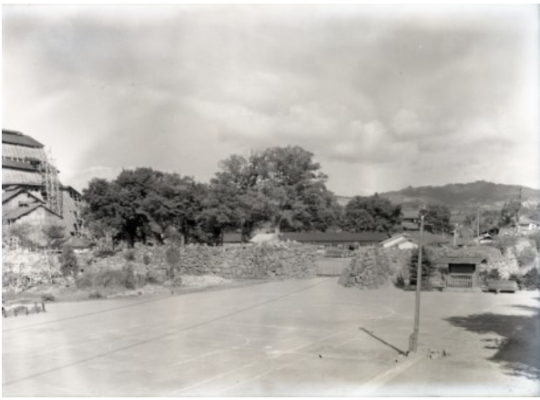
図版28 天守昭和修理時の黒門付近
