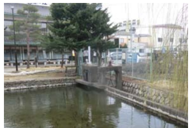
堀水排水口（北西外堀西端）
