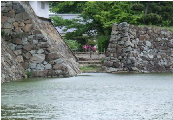
水門跡（月見櫓脇 西から）
