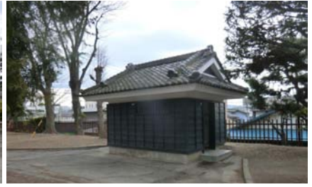
トイレ（二の丸西側）
