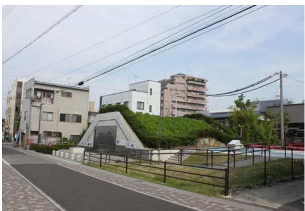
西総堀土塁（南東から）
