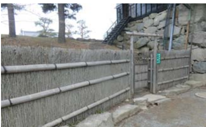
笹垣と門扉（黒門北側）
