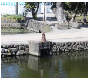
水門（内堀北西）
