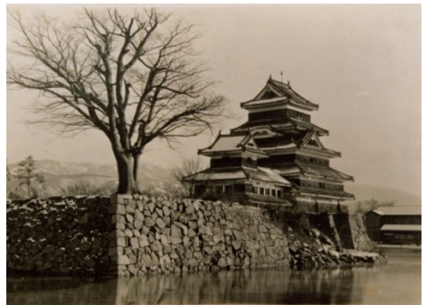
図版15 埋門北側石垣の崩落（昭和5年）
