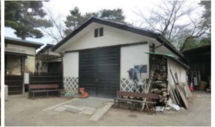
倉庫と作業員詰所（左奥）
