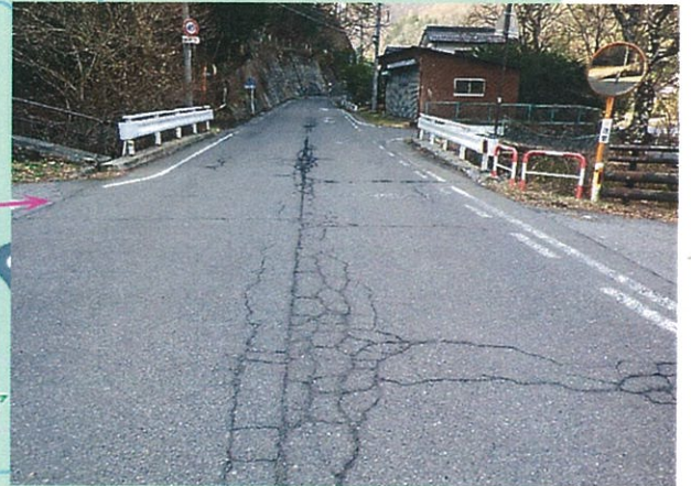
「宮沢橋」長さ10m・幅8m 規制期間 5月中旬～8月中旬予定
