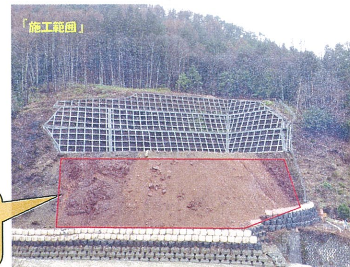
【2段目法面・1段目法面】 法面掘削、吹付法砕工、鉄筋挿入工、 植生基材吹付、排水構造物工
