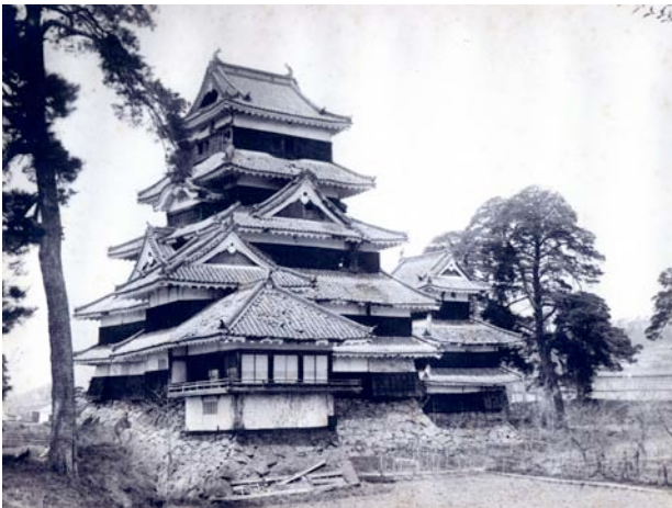
古写真8 解体修理前の松本城天守 (東南面)
