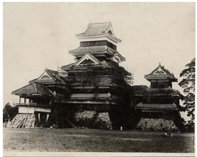
古写真11 修繕中の天守閣
