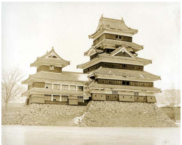
古写真 32 解体修理前の松本城天守（西面）
