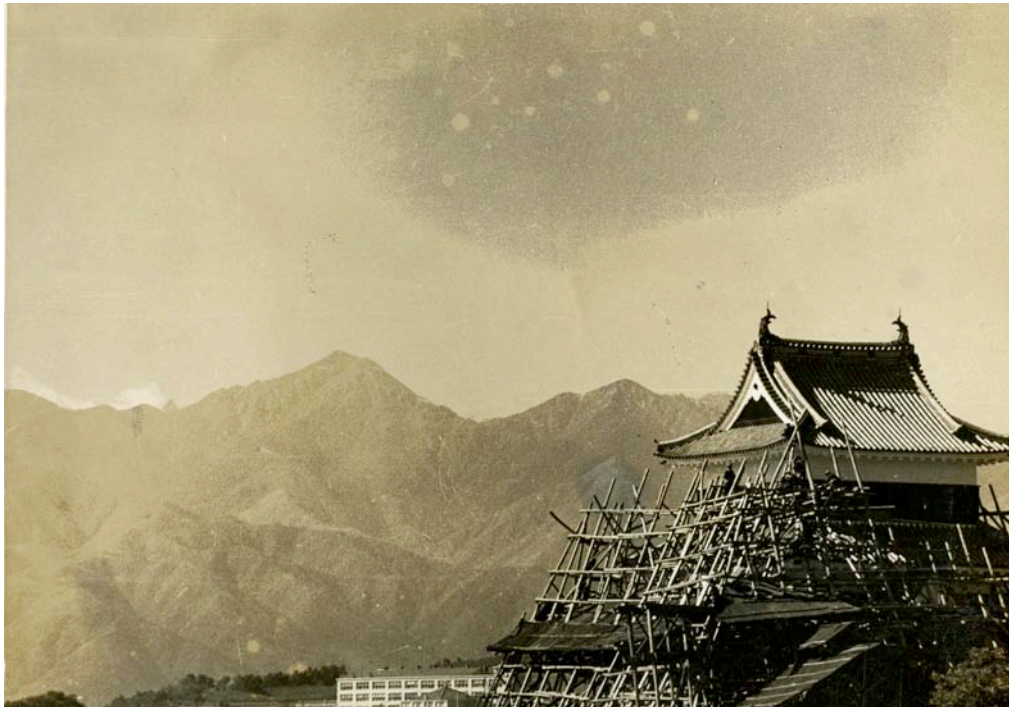
古写真 39 解体復元工事中の松本城
