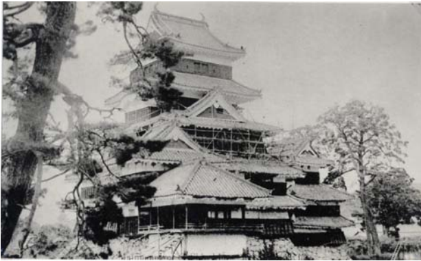
古写真 12 天守閣保存会により修理中の松本城
