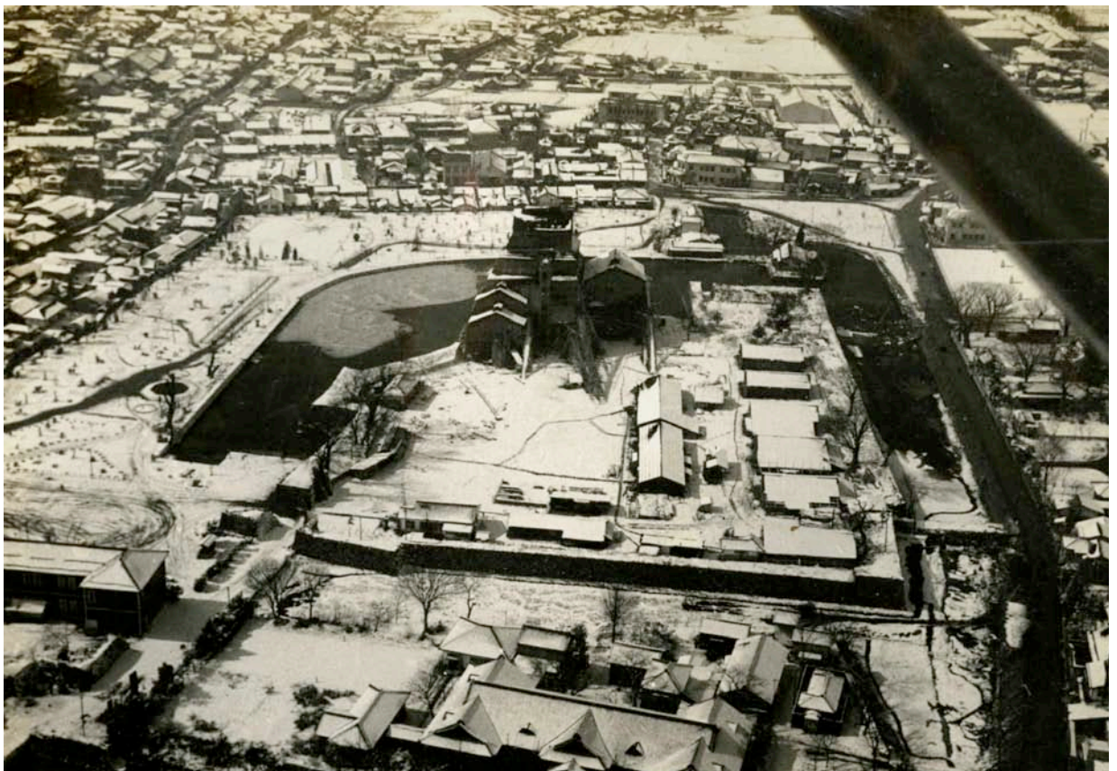
古写真 43 解体復元工事中の松本城
