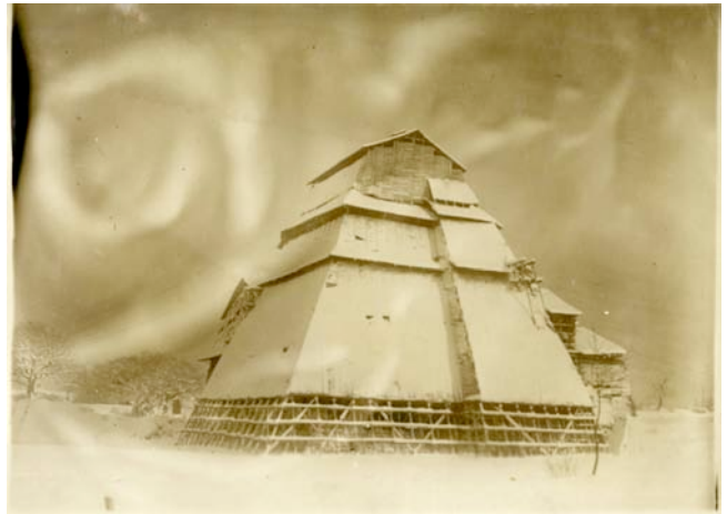
古写真 38 解体復元工事中の松本城 (昭和 26 年冬解体中)
