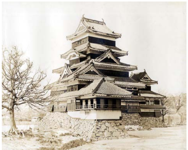
古写真 30 解体修理前の松本城天守（東南面）
