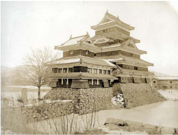
古写真 27 解体修理前の松本城天守（西北面）
