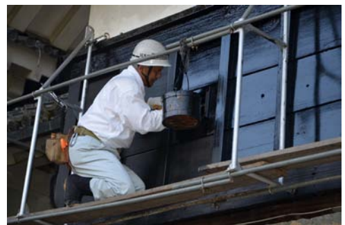
写真 2-2 松本城天守外壁下見板漆塗り工事状況詳細
