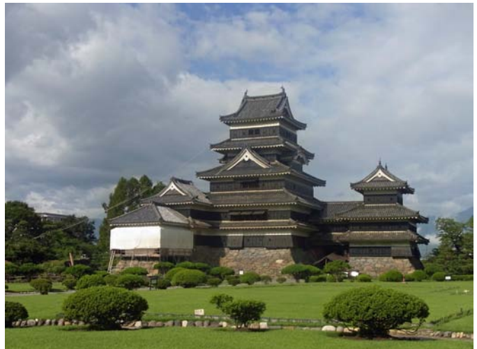
写真 2-1 松本城天守外壁下見板漆塗り工事状況（9月～10月）全景
