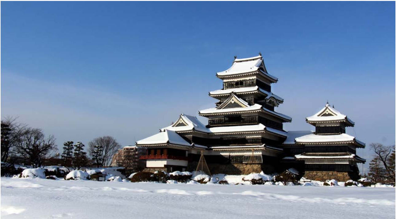
写真 4-12 積雪時の松本城の状況（北東より）
