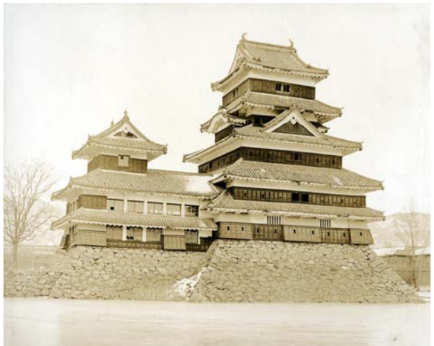
古写真 32 解体修理前の松本城天守（西面）
