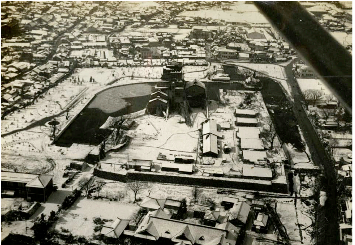
古写真 43 解体復元工事中の松本城
