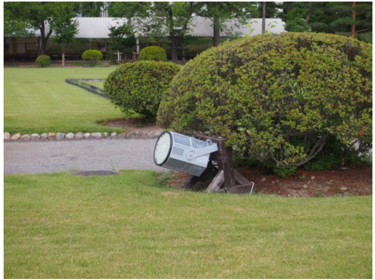
写真 3-14 ライト（LED）設置状況
