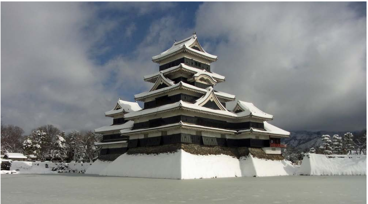
写真 4-13 積雪時の松本城の状況（南西より）
