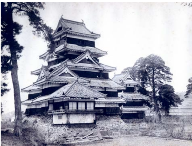
古写真8 解体修理前の松本城天守 (東南面)
