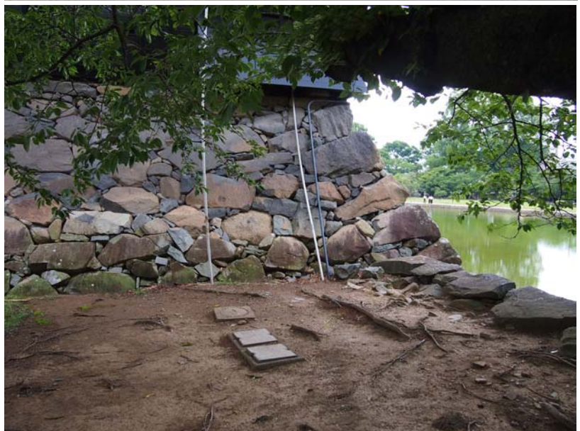
写真 5-10 避雷針地中放電用埋設コンクリート製斗
