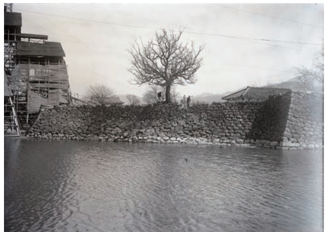
古写真 41 解体工事月見櫓東南方石垣修理竣工(昭和 29 年)
