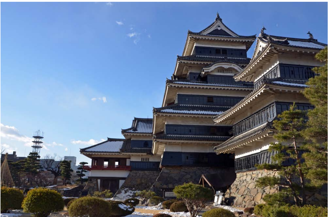
写真 1-9 松本城天守（北より撮影）
