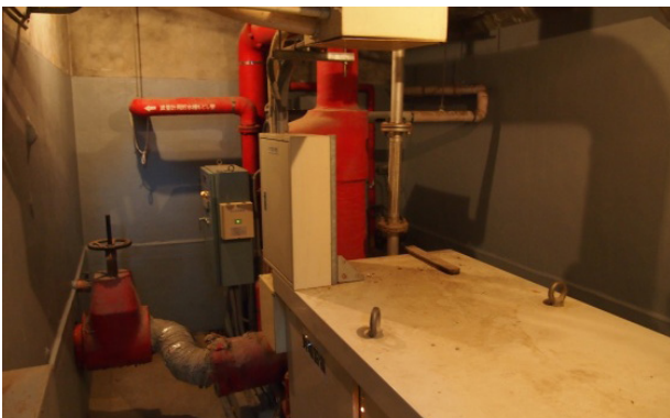
写真 4-5 屋内消火栓（左上）
