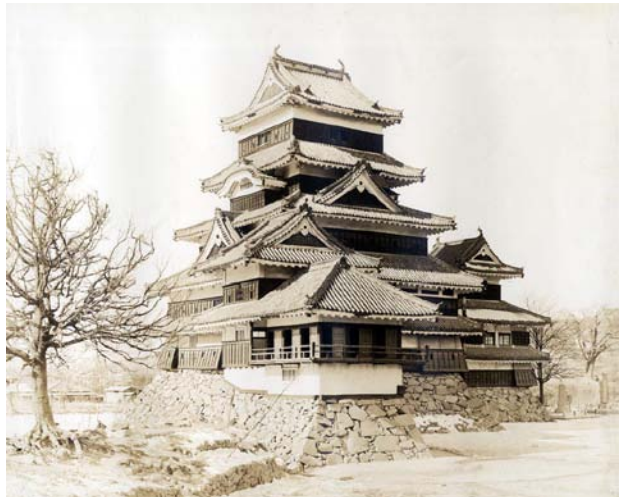
古写真 30 解体修理前の松本城天守（東南面）
