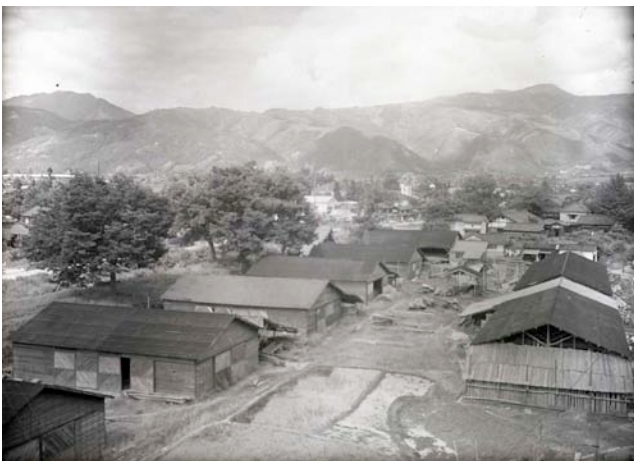
古写真 40 解体復元工事中の松本城 (機材関係)
