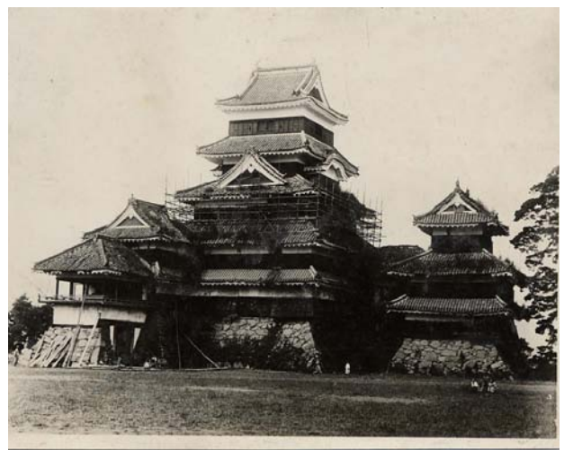
古写真11 修繕中の天守閣
