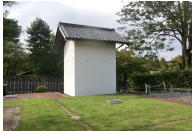
御金蔵（土蔵 東から）
