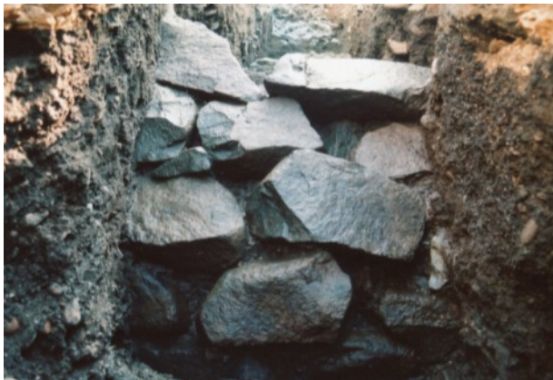
南外堀三の丸側の石垣（試掘調査時）
