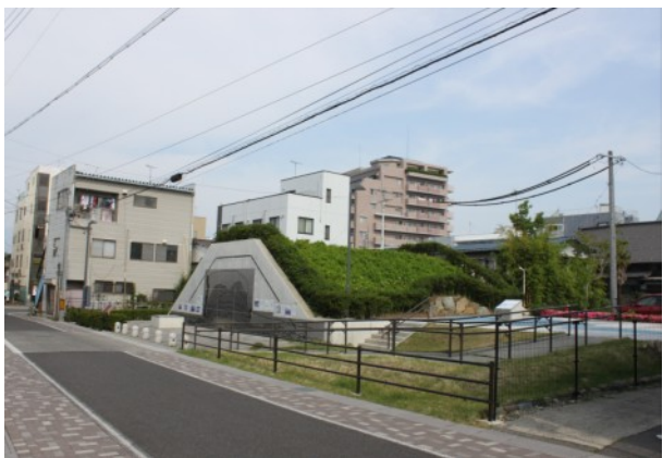
西総堀土塁（南東から）
