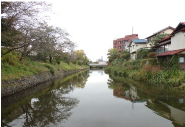
東総堀（北半部 北から）
