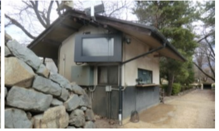
埋門券売場（現在は使用していない）
