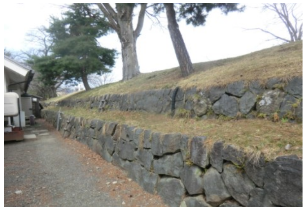
本丸東側内周土坡、石垣（南から）
