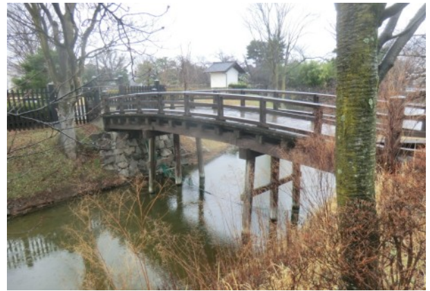
二の丸御殿裏御門橋（復元 北東から）
