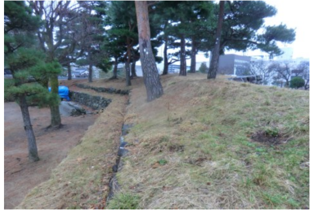
本丸南側内周土坡、石垣
