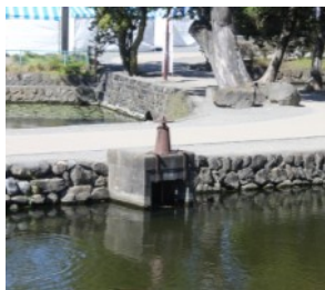
水門 (内堀北西)
