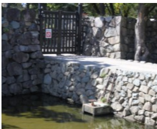
水門 (北裏門土橋)
