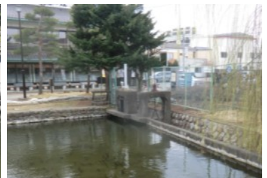
堀水排水口 (北西外堀西端)
