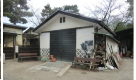
倉庫と作業員詰所（左奥）
