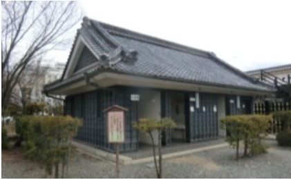
トイレ (二の丸御殿跡東)
