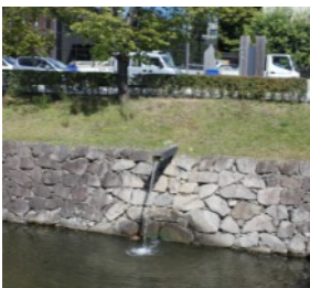
地下水投入口 (北外堀)
