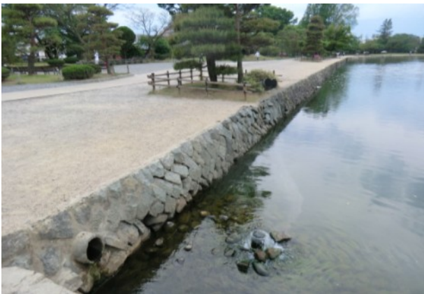
内堀南面石垣（埋立により付加された石垣）と給水口
