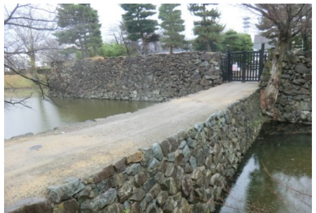
北裏門土橋、管理用門（北から）
