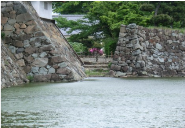
水門跡（月見櫓脇 西から）
