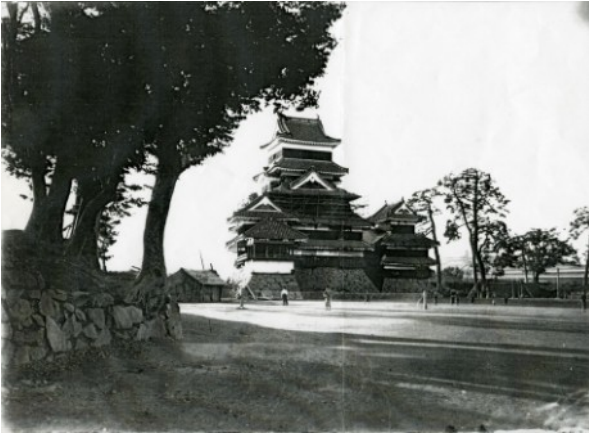
図版14 グラウンドとなっていた本丸（明治43年）
