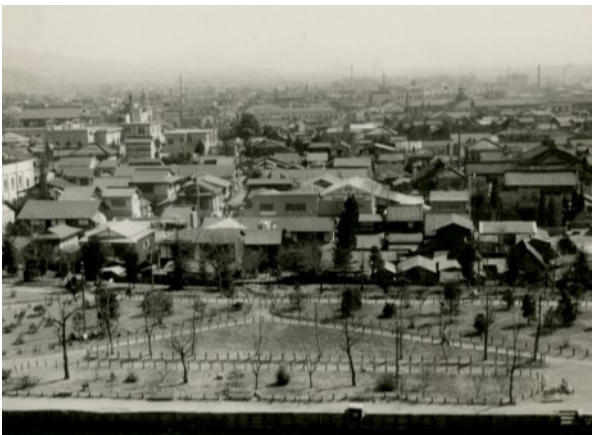
図版32 植樹前の二の丸、内堀沿いは矢板（昭和31年）
