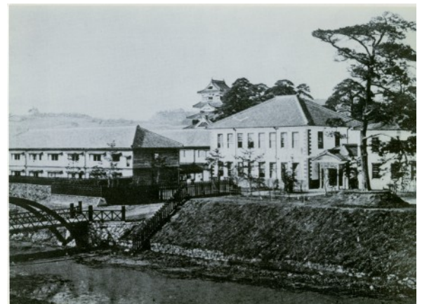
図版19 旧制松本中学深瀬橋（明治22年頃）
