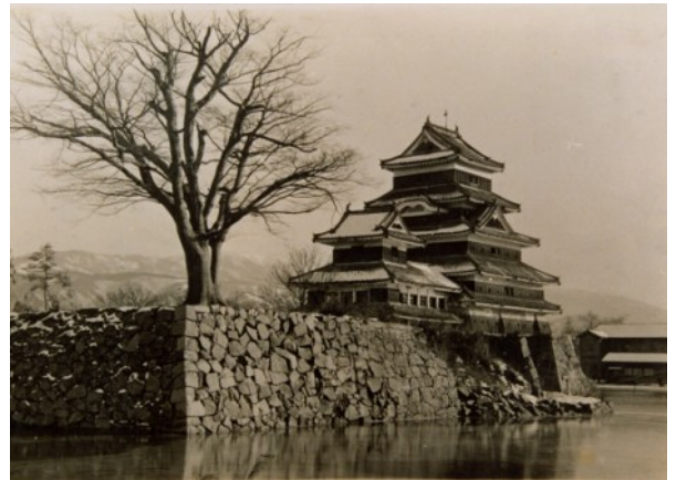
図版15 埋門北側石垣の崩落（昭和5年）
