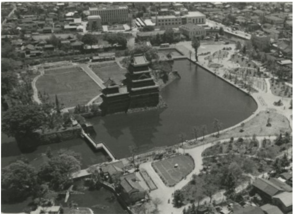
図版30 整備された本丸・二の丸（昭和31年）
