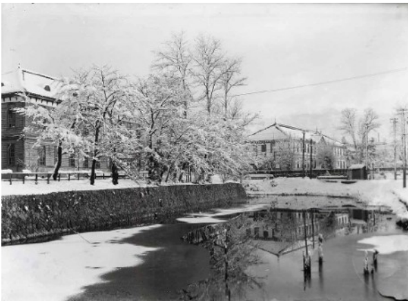
図版22 南外堀東側の石垣と博物館（昭和10年以前）
