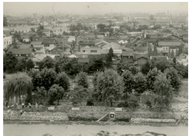
図版33 改修中の内堀南面石垣と植樹（昭和31年）
