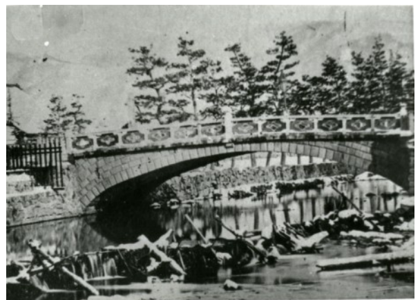
図版27 大手門石垣の石を転用した千歳橋（時期不詳）
