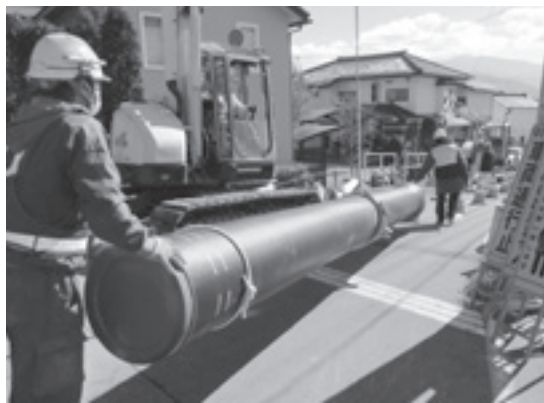
水道管の取り換え工事
