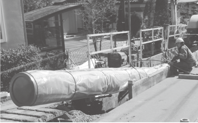
▲水道管の取り替え工事
