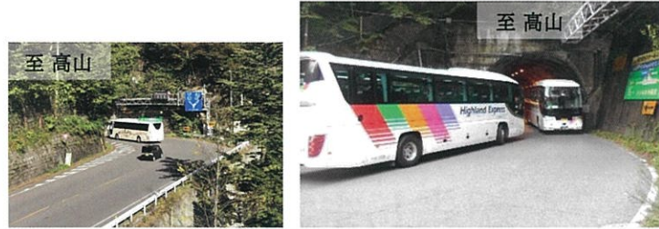
大型車同士のすれ違いが困難な、現道の入山トンネル 対向車とのすれ違いによる滞留が発生しています。
