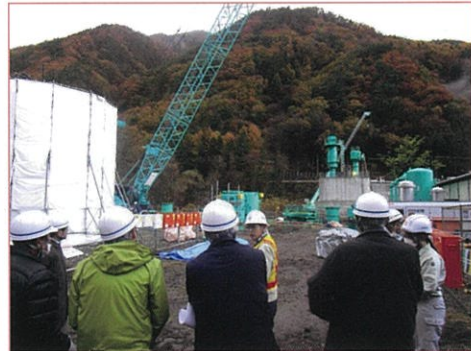
県道大野田梓橋停車場線 八景山 岩盤崩落箇所を迂回する新設橋梁の工事
