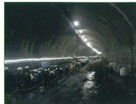
トンネル内部を約300m歩いて見学しました
