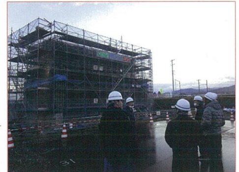
松本波田道路 (仮称)新村高架橋 国道158号と上高地線を跨ぐ橋梁の下部工事
