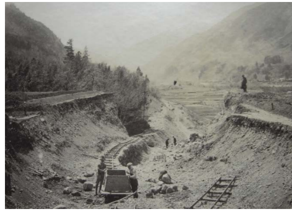
↑ 島々線（上高地線）工事のようす 波田～島々間
