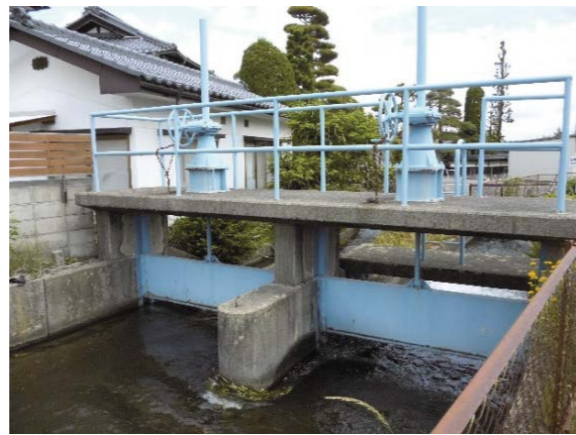
↑ 新村堰上新分水工
