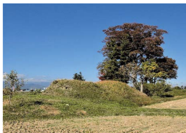
↑ 残っている高綱堰の左岸の一部
