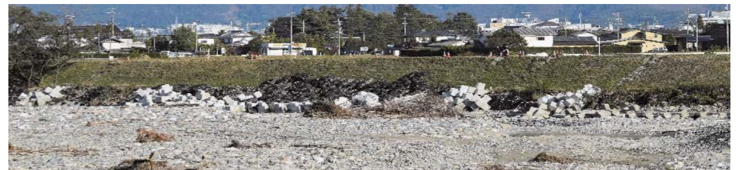
↑ 令和3年（2021）8月大雨による梓川右岸堤防浸食
