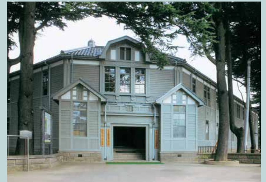
本館 正面全景(西北より)
