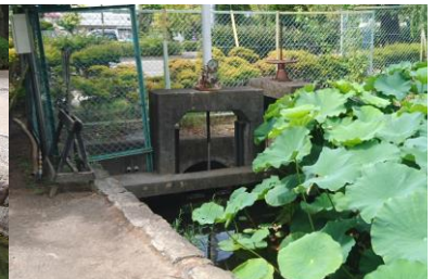
堀水排水口(北西外堀西端)
