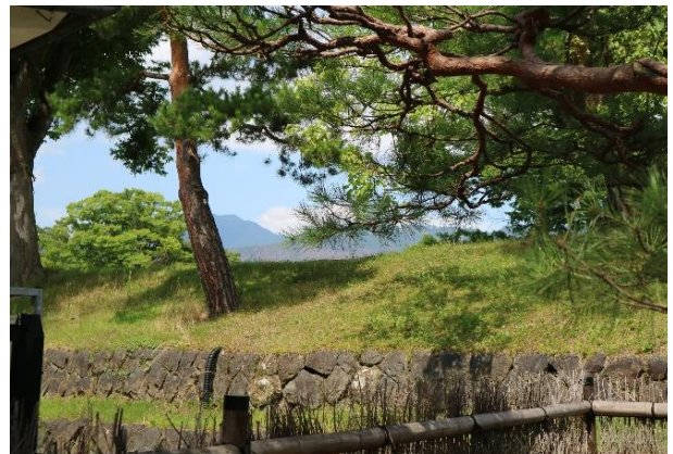
本丸東側内周土坡、石垣（南から）
