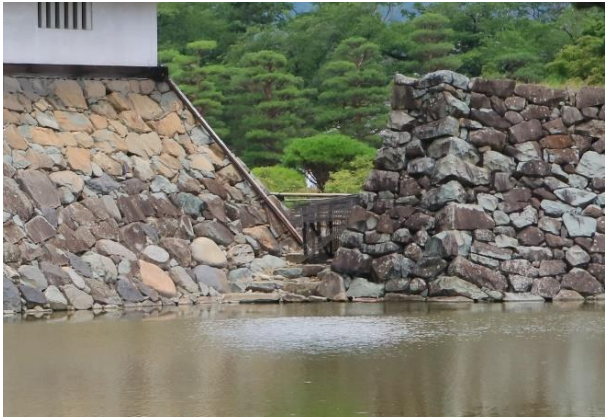
水門跡（月見櫓脇 西から）
