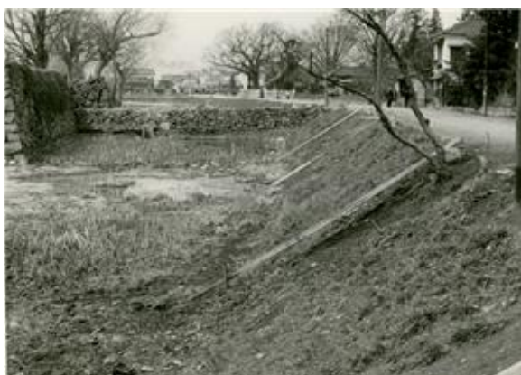
図版42 改修中の北外堀北面土坡
