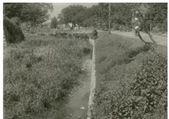
図版43 北外堀北面土坡の堀石垣
