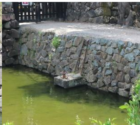
水門(北裏門土橋)
