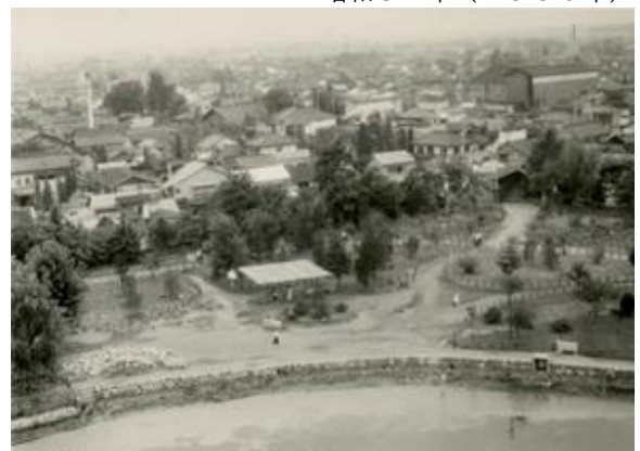
図版39 改修中の内堀南・西面石垣
