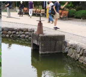
水門(内堀北西)
