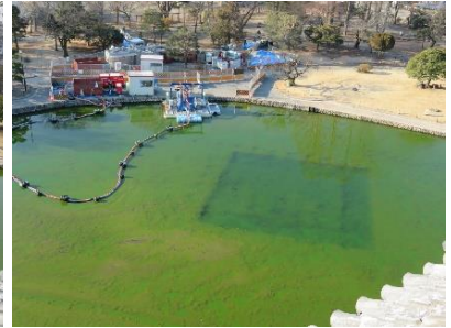
浚渫後の内堀
