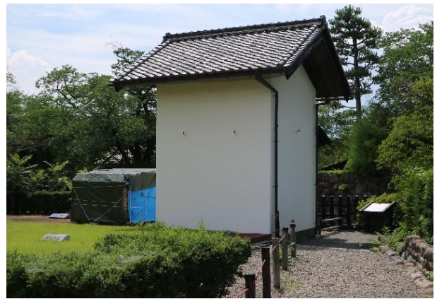
御金蔵(土蔵 東から)
