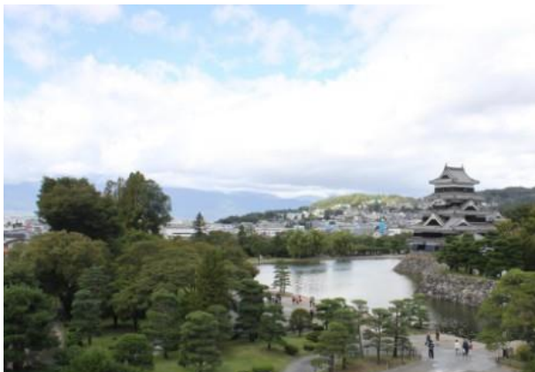
二の丸(南東から)
