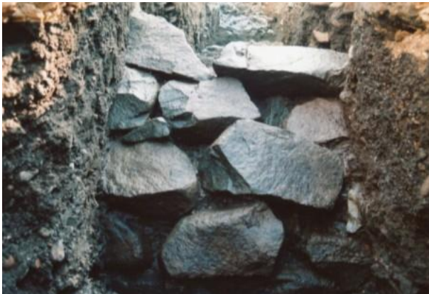
南外堀三の丸側の石垣(試掘調査時)
