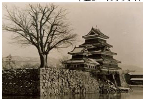
図版23 埋門北側石垣の崩落 昭和5年(1930年)
