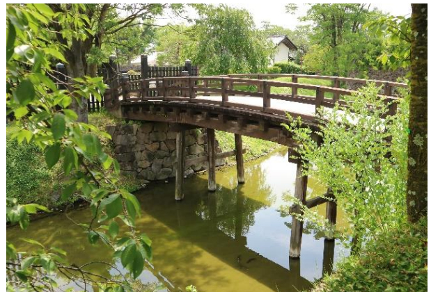
二の丸御殿裏御門橋(復元 北東から)
