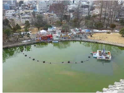
浚渫中（浚渫の様子）
