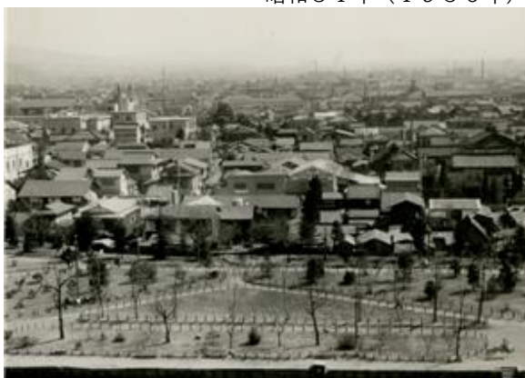
図版40 植樹前の二の丸、内堀沿いは矢板
