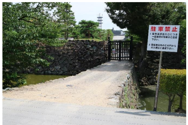
北裏門土橋、管理用門（北から）
