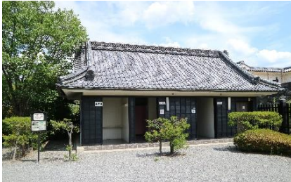
トイレ(二の丸御殿跡東)
