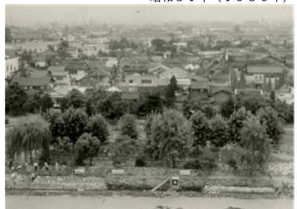
図版41 改修中の内堀南面石垣と植樹
