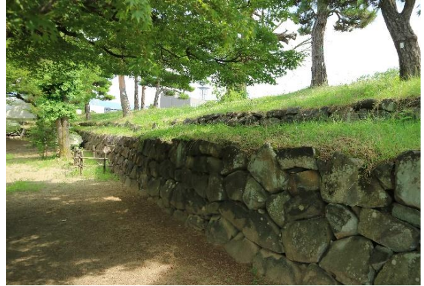
本丸南側内周土坡、石垣
