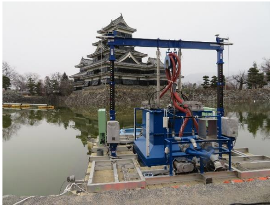
水底土砂ポンプ浚渫工法の様子（令和2年度実証実験時）
