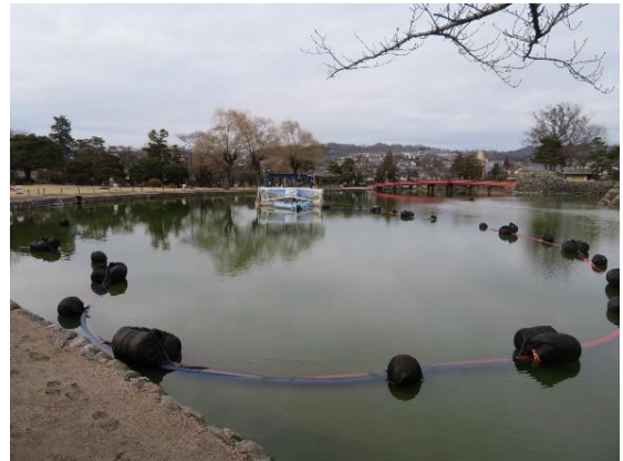
水底土砂ポンプ浚渫工法の様子（令和2年度実証実験時）
