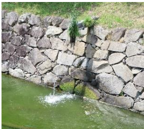
地下水投入口(北外堀)
