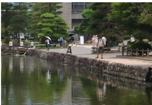
内堀南面石垣(埋め立てにより付加された石垣)と給水口
