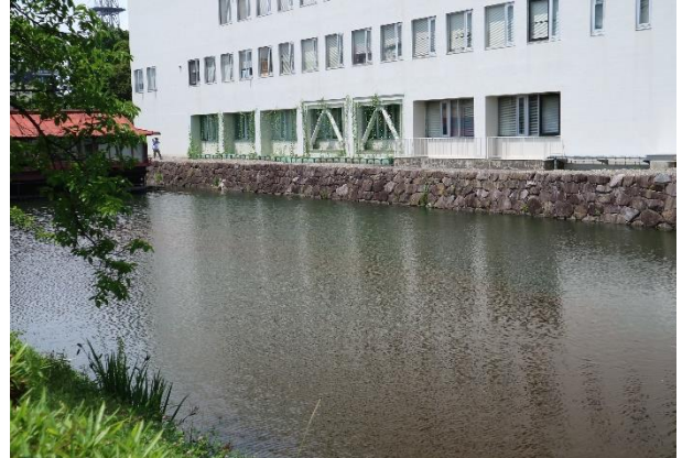
東総堀北半部南側(北東から)
